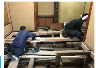
仲三階の床補強工事
